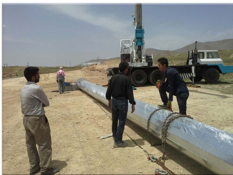
نصب برج پرچم
