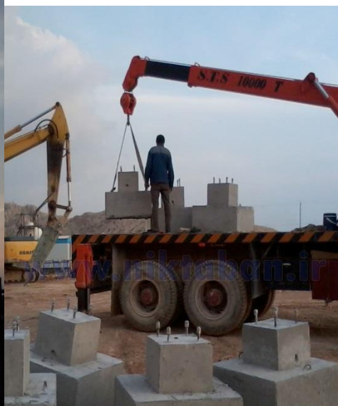
فوندانسیون چراغ خیابانی خورشیدی مدل پرتو ۳ محل نصب : پارس جنوبی - عسلویه - پتروشیمی بوشهر
