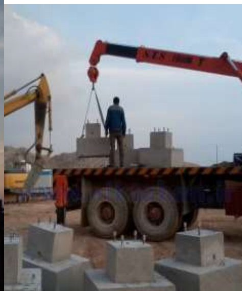
فونداسیون چراغ خیابانی خورشیدی مدل پرتو ۳ محل نصب : پارس جنوبی - عسلویه - پتروشیمی بوشر
